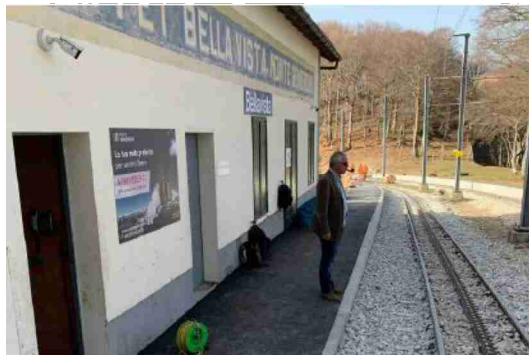
La stazione Bellavista dopo i lavori
