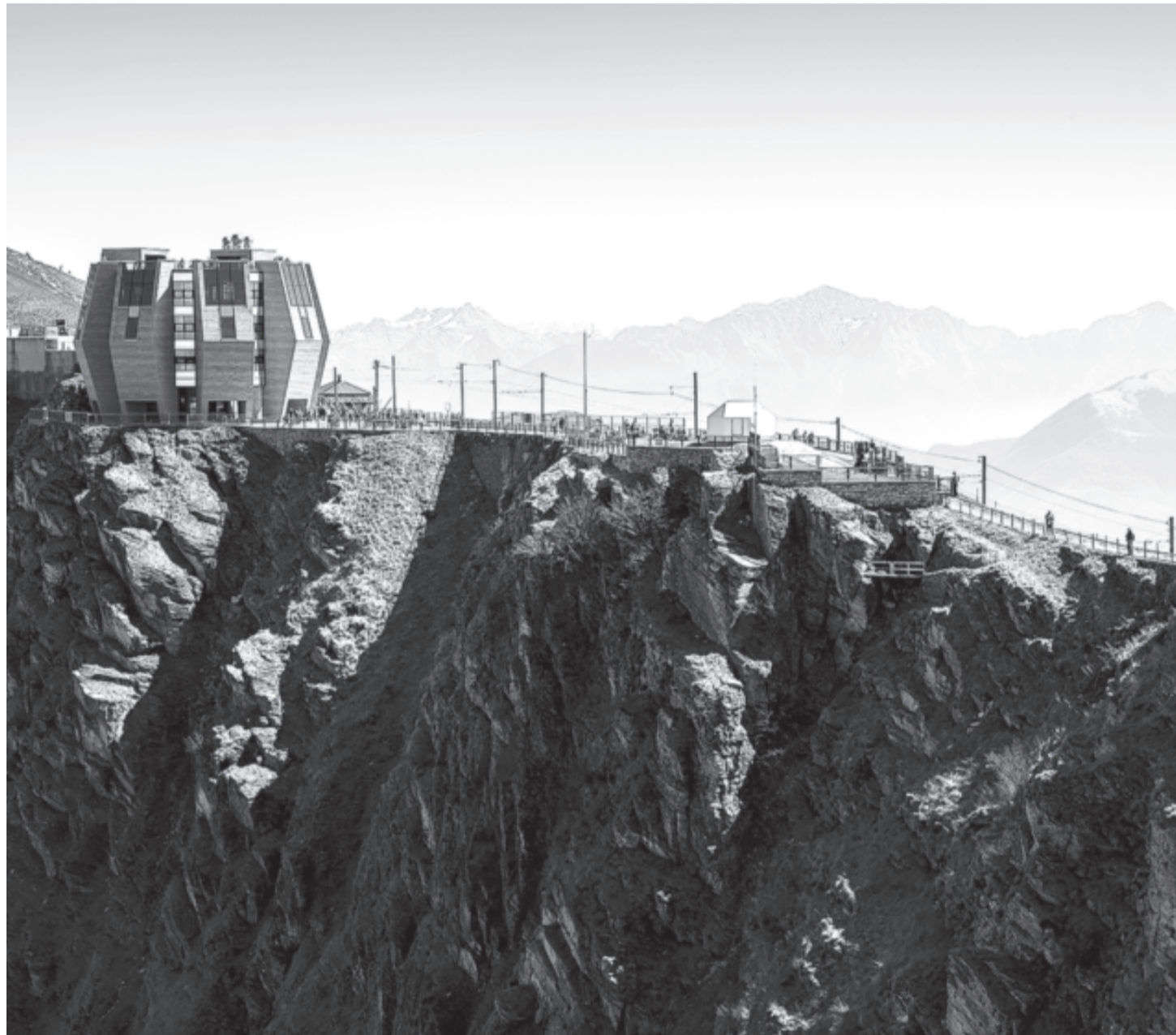
Nördlich des Gipfelrestaurants stürzt sich eine über 300 Meter hohe Felswand in die Tiefe, im Süden erstrecken sich sanfte Alpweiden
